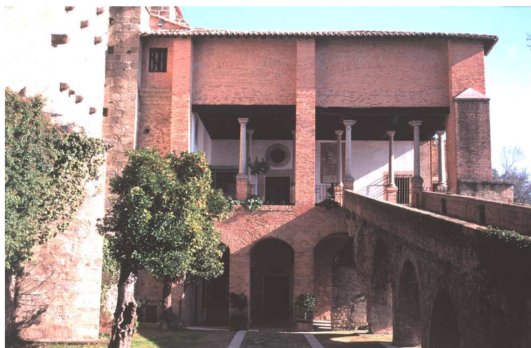
Fig. 4. Frente oeste del palacio con la rampa de acceso al pensil
