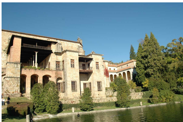
Fig. 1. Vista general del Palacio de Carlos V en Yuste
