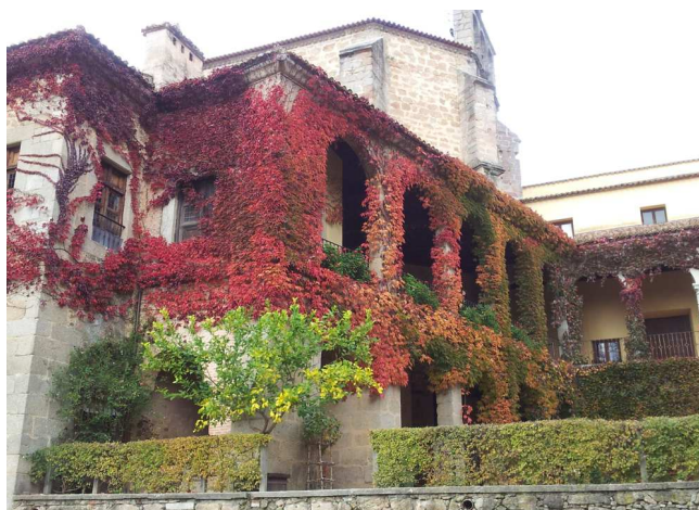
Fig. 7. Extremo occidental de la Galería del emperador en la que se aprecia la estancia de la estufa
